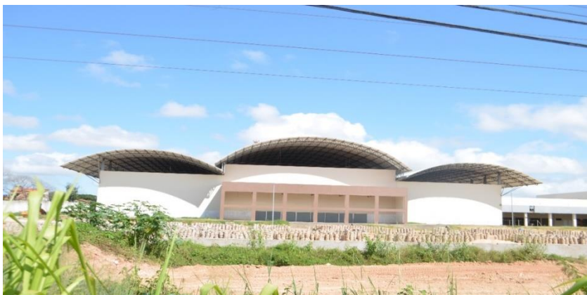
Figura 6: Foto da tomada frontal do Centro de Convenções de Marabá. Obra em construção.
