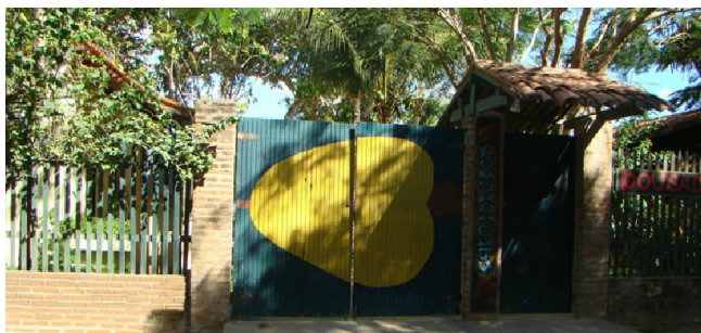
Figura 46 – Vista Da Pousada Caju. Fonte: Pousada Caju (2013)
