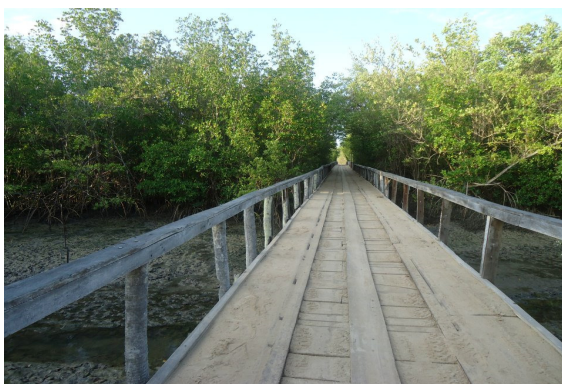
Figura 30 - Ponte de madeira do Mangue Seco. Fonte: NASCIMENTO, J. T. (2013).
