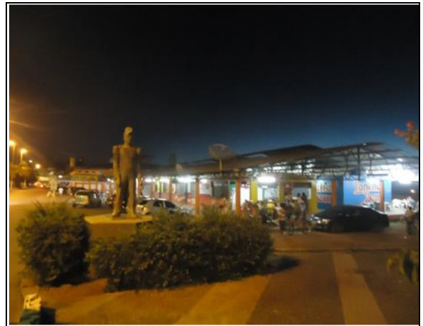
Foto 8 - Rodoviária de Tianguá
