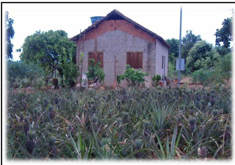
Foto 3 - Monte Alegre de Minas (MG): residência familiar no Assentamento Vale do Sol II
