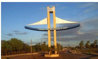
Imagem 2: Pórtico de Entrada – mensagem de boas vindas
